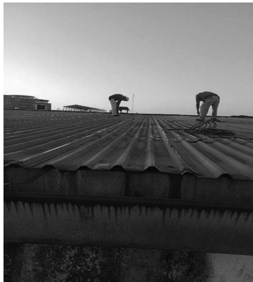
Figura 1. Techos de naves
