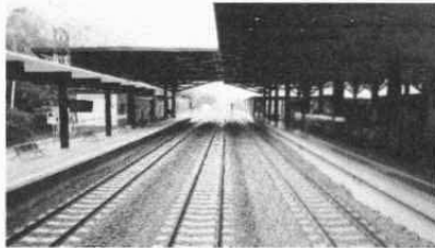
Ilustración 12. Estación del Tren Maya "Boca del Cerro".
