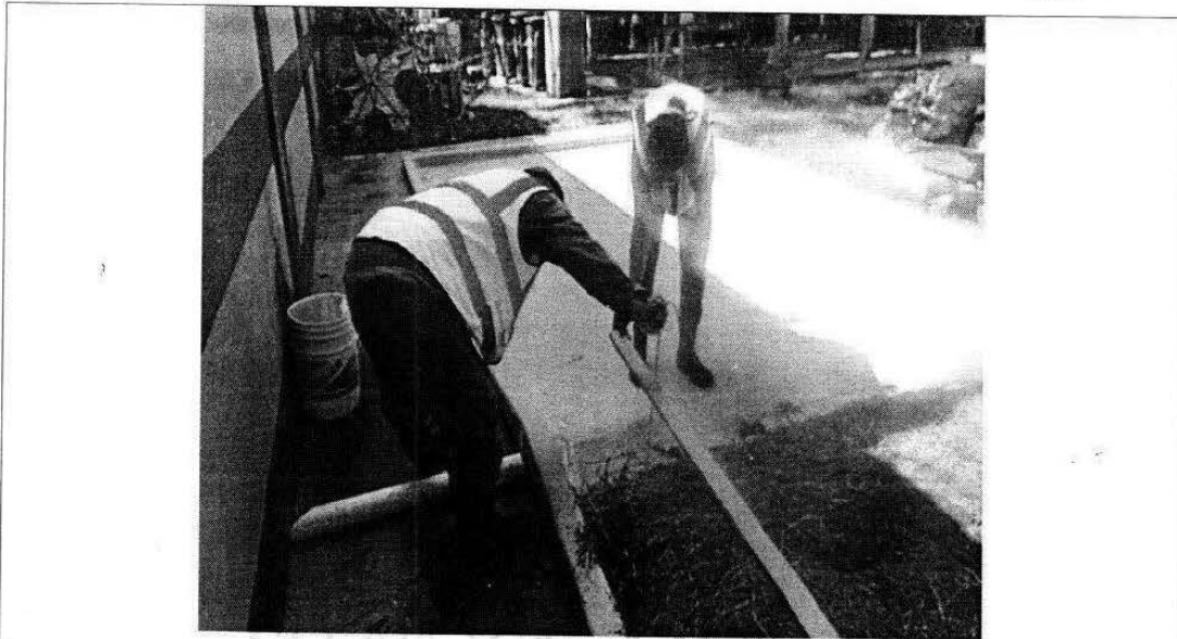
Figura 9. Inicio de compostaje, construcción pila 1
