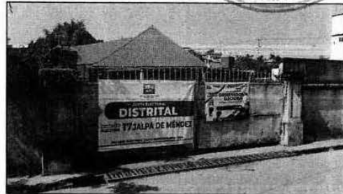
Junta Electoral Distrital 17 Jalpa de Méndez en Calle del Retén No. 04, Poblado Amatitán, Jalpa de Méndez, Tabasco
