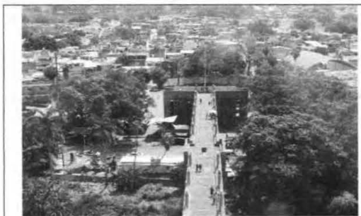
Fotografía 7. Puente peatonal La Esmeralda del Sureste
