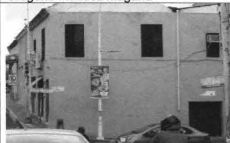
Fotografía 24. Duplicación, deterioro y falta de estandarización de la señalética
